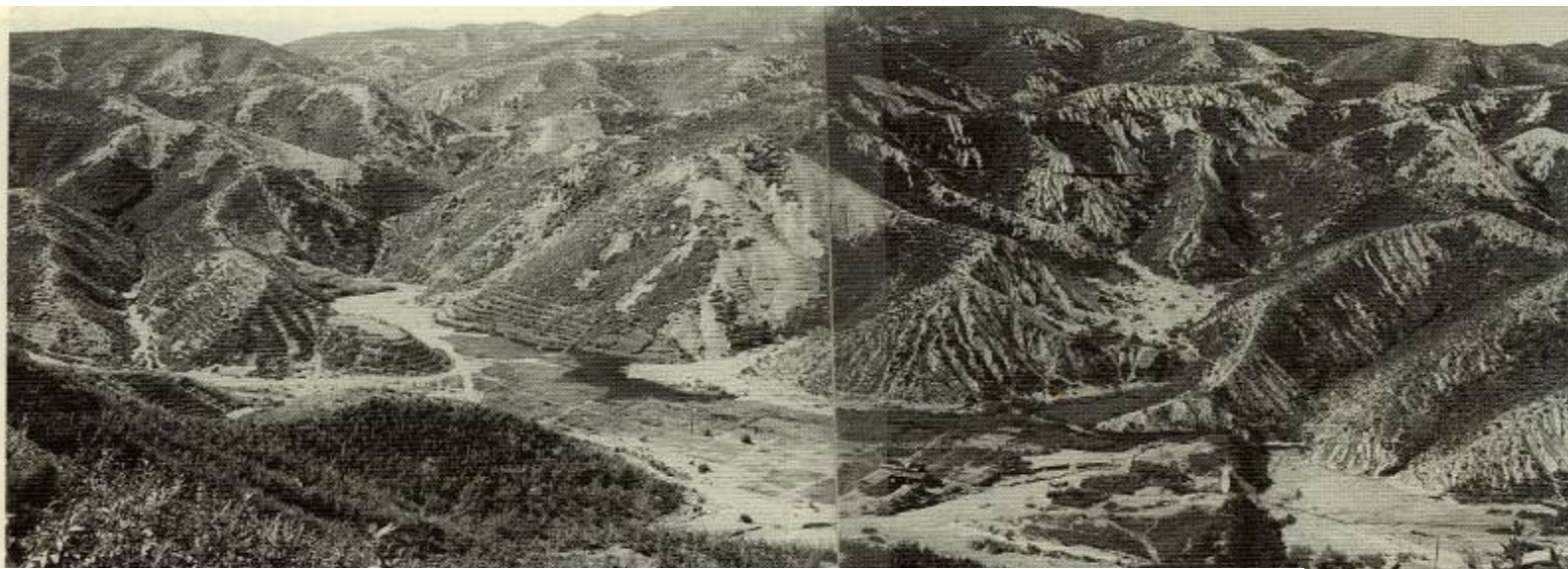
志池上流（西方）の荒廃
