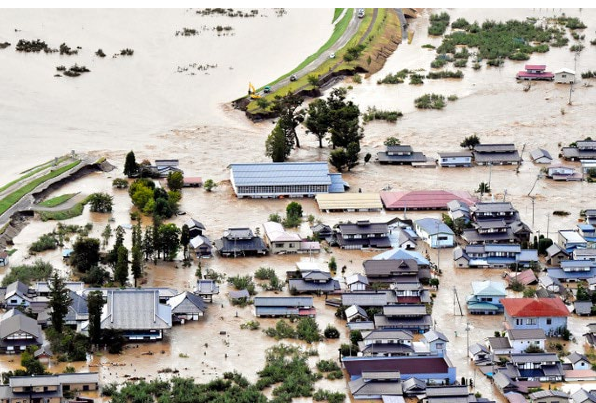
2019年東日本台風の被害(千曲川の堤防決壊による氾濫)
